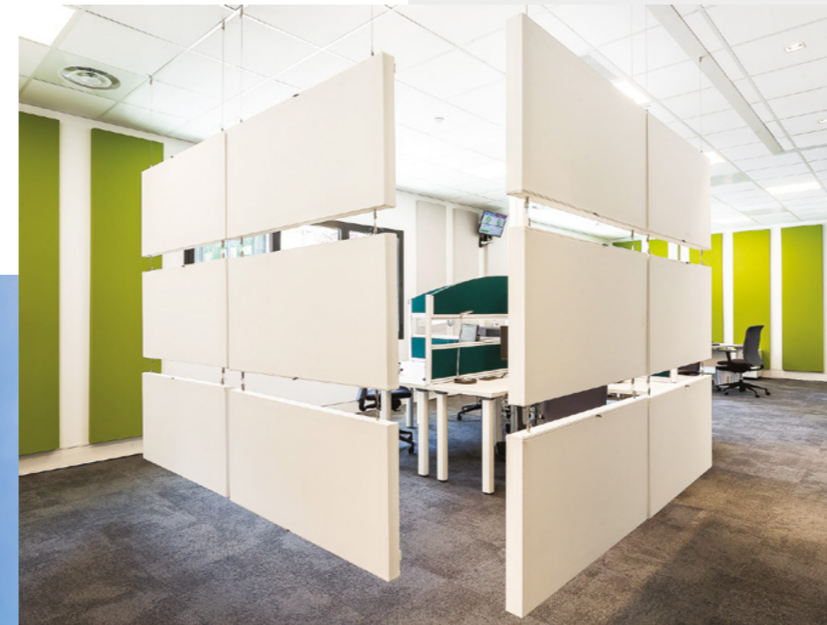
Montage en échelle pour cloisonner les espaces
